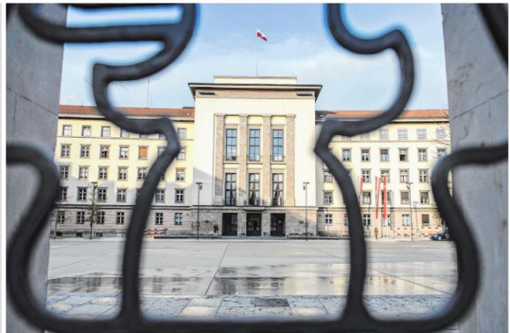
Eine künstlerische Intervention sollte daran erinnern, dass das Landhaus ein Nazi-Bau ist. Keiner der eingereichten Vorschläge wird umgesetzt. Foto: Böhm, Leitner
